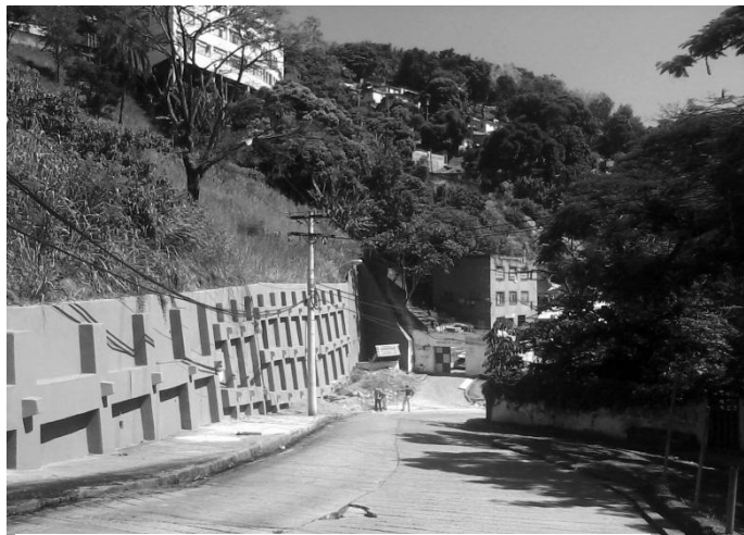
Imagem 02. Principal via de acesso ao Morro.
