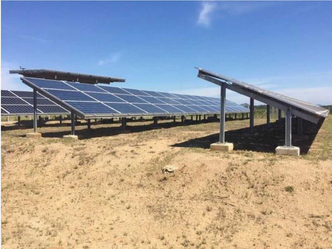
FIGURA 1 - Módulo e placas instaladas no Campus do IFF em Cabo Frio. Foto: Gustavo Garcia.
