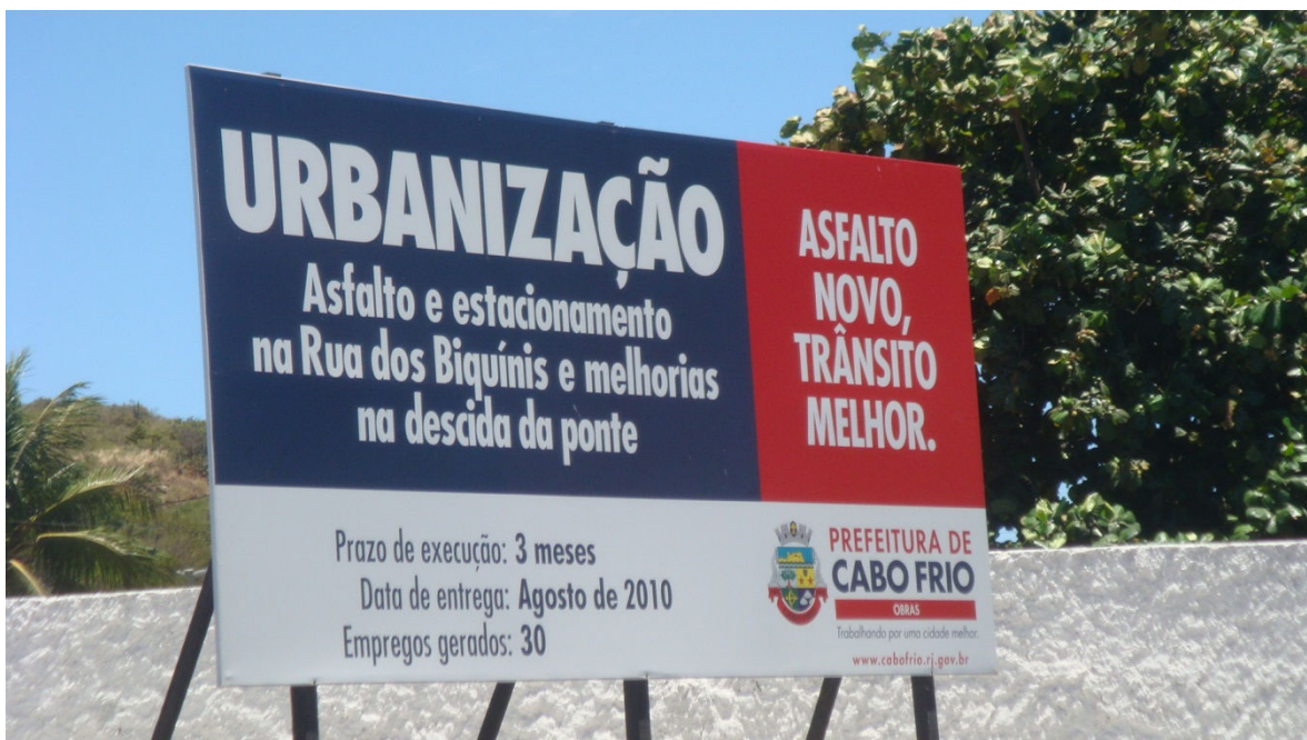
Imagem 1 – Placa indicativa de obra no estacionamento público da Gamboa
