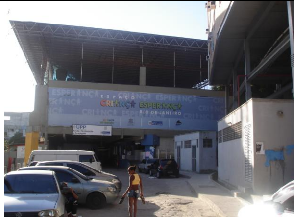
Prédio onde situa a Academia Nobre Arte, no Cantagalo.
