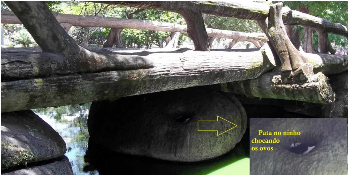
Figura 33 – Pata chocando ovos em cavidade em estrutura de ponte
