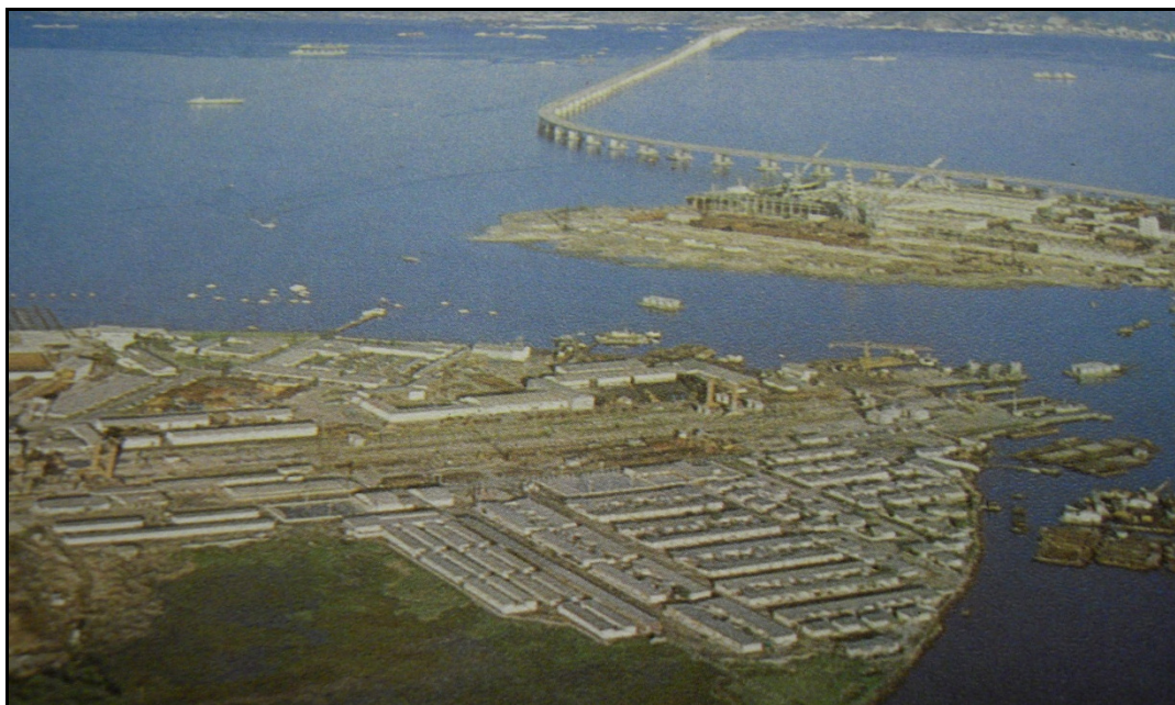
Foto aérea do canteiro de obras, com a ponte construída ao fundo. Fonte: RODAGEM, BRASIL, s/d.
