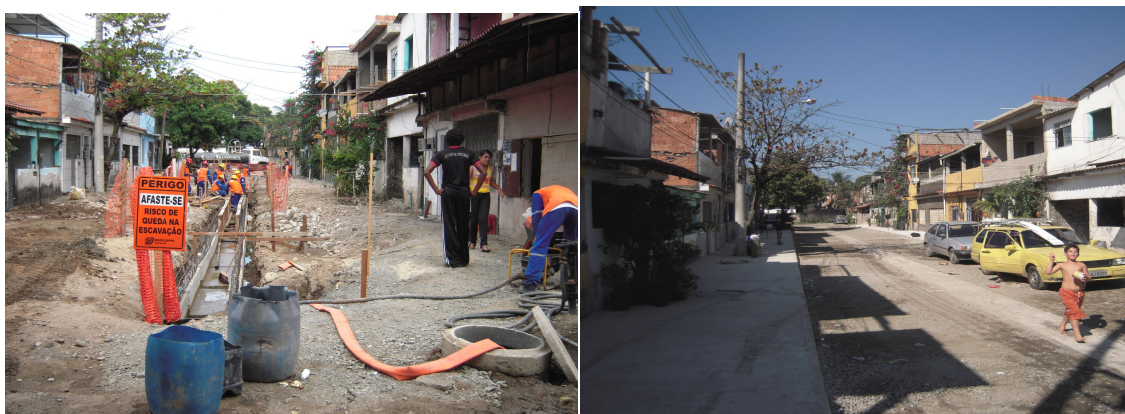
A Rua das Rosas, antes e depois das obras de drenagem. Fotos: Leticia de Luna, 2010.
