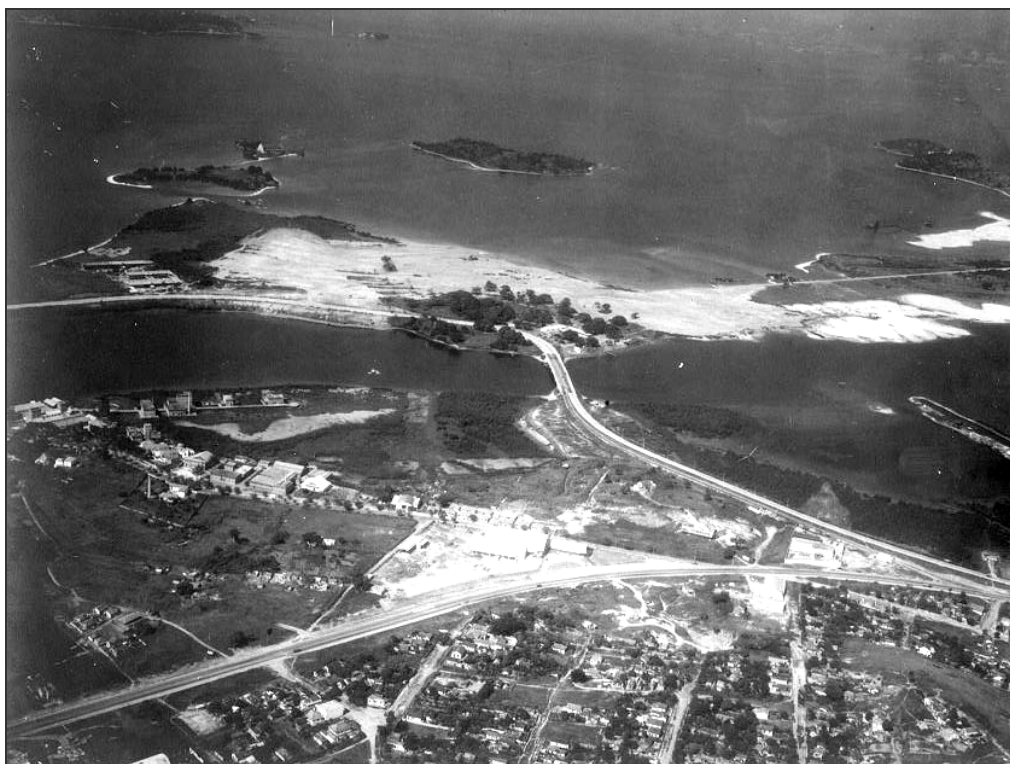
Início das obras de aterro hidráulico. Ao fundo, as ilhas de Baiacu, das Cabras e do Catalão ainda separadas pelo mar. Fonte: Arquivo Histórico do ETU, 1951.
