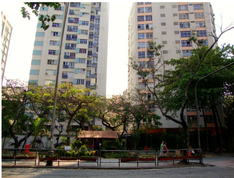
Foto 1.11 – Rua Marquês de Abrantes, 4: um dos endereços antigos da Gafieira Estudantina, em quadra de sobrados demolidos no Flamengo.
