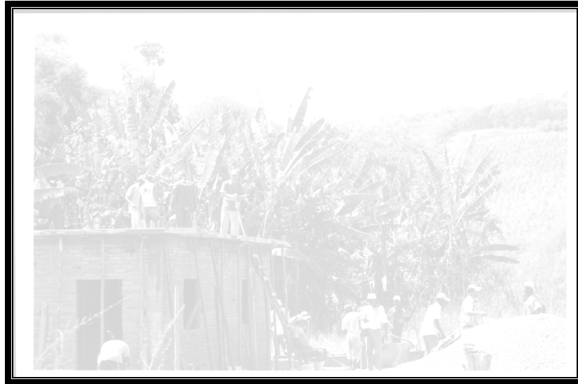
Foto 5. Parentes, vizinhos e companheiros associados em mutirão para construção da casa (2006)
